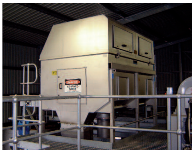
Установка фильтрующего барабана HUBER RoMesh® для очистки промышленных сточных вод
