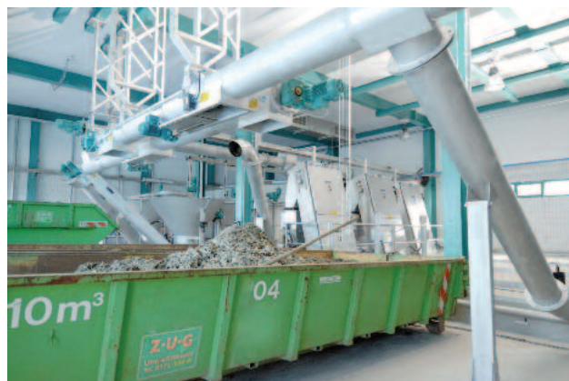
Шнековый транспортер HUBER ROTAMAT® Ro8, осуществляющий отвод отбросов
